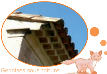
Génoises sous toiture
