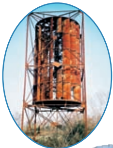
Ancienne éolienne agricole de Pin Fourcat
