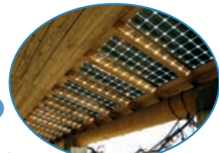
Panneaux solaires photovoltaïques semi-opaques intégrés dans un auvent
