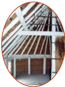
Toiture en sagne
