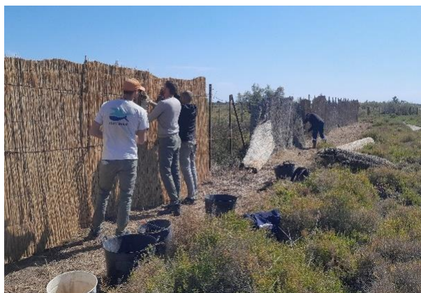
Photo 43 – Chantier de renouvellement des palissades de l'observatoire du Saint-Seren
