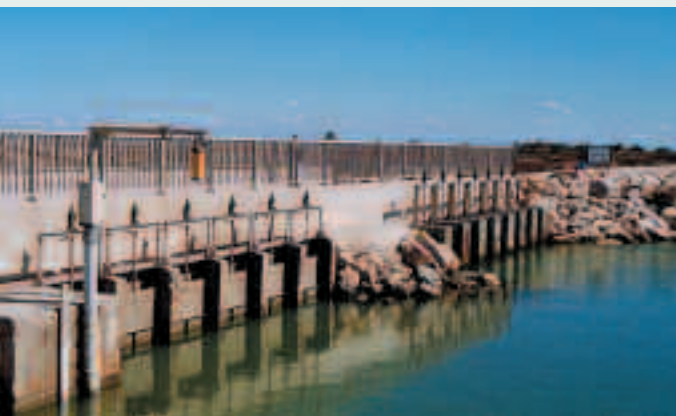
Le pertuis de la Fourcade, lieu d'échanges hydraulique et hydrobiologique entre la mer et les étangs.
