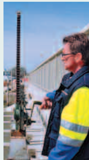
Manœuvre des vannes du pertuis de la Fourcade par Gilbert Liabœuf.
