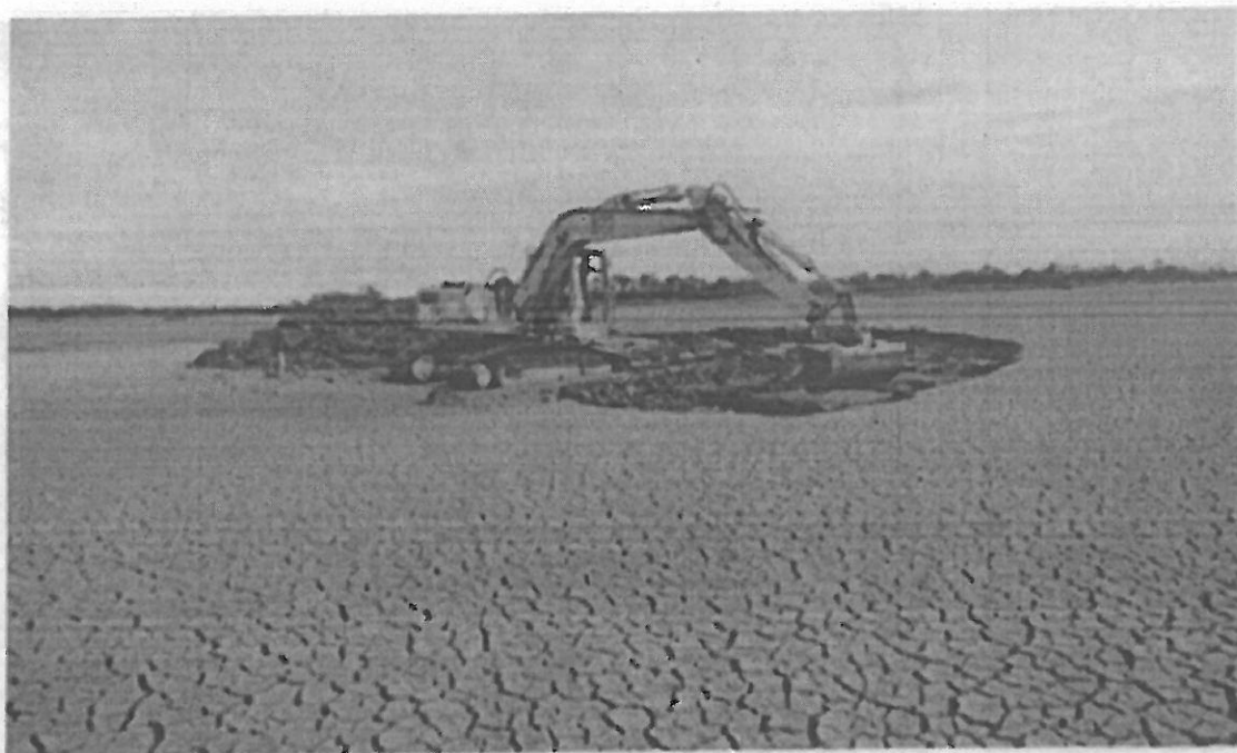
Pelle mécanique au travail : la construction de l'îlot commence
