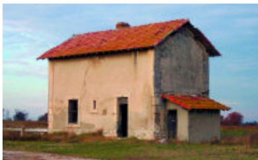
Une ancienne gare en Camargue, vestige d'une époque révolue. Droits réservés.
