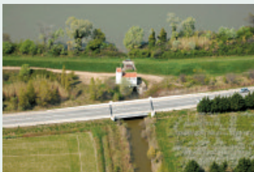
Station de pompage sur le petit Rhône. Les mesures de gestion de l'eau, nécessaires à la conservation des habitats dans le cadre de Natura 2000 doivent être cohérentes et complémentaires de celles inscrites au Contrat de delta (Visages de Camargue mai-juin 2008).
