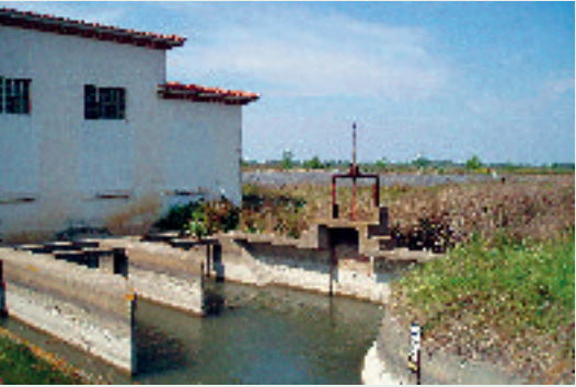
Station de pompage d'Antonelle.
