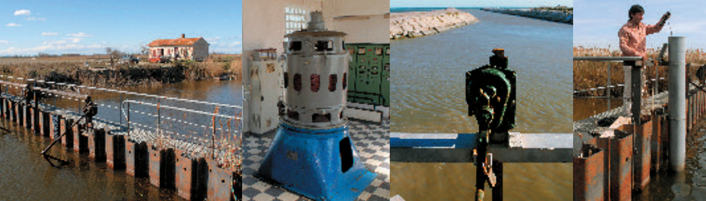
Clapets entre le canal de Rousty et l'étang du Vaccarès / Pompe de la station d'Albaron/ Pertuis de la Fourcade / Mesure des hauteurs d'eau au nord Vaccarès (photographies : Jean Roché).
