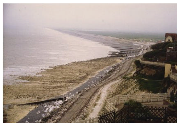
Travaux de protection d'Ault-Onival : épi sur le platier, enrochement et remblai en pied de falaise, console bétonnée ("casquette") au-dessus
