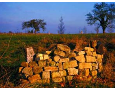
Petit muret de pierres sèches, aménagé avec des gîtes à insectes
