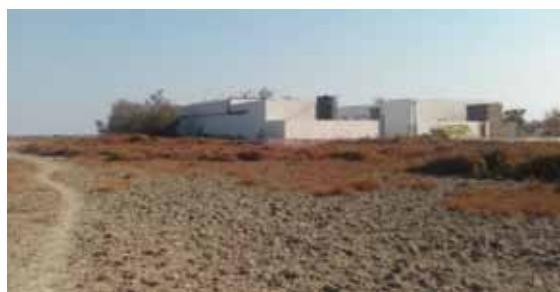
Station d'épuration des Saintes Maries de la Mer. Crédit photo : ACCM
