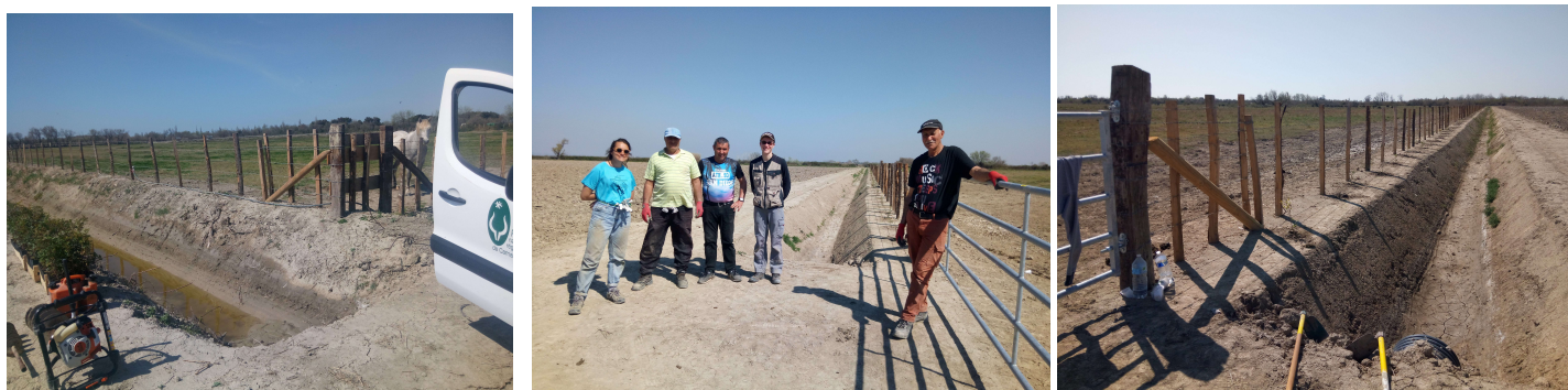
Figure 10. Chantier de plantation aux Cabanes di Ego (© Anne Vadon PNRC)
