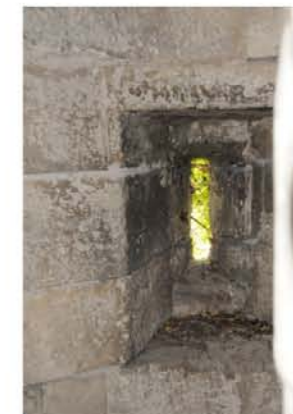
Ouverture dans la tourelle de l'escalier à vis en partie haute
