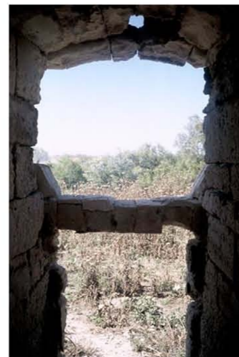
Porte percée dans le niveau 1 lors de la transformation en domaine agricole
