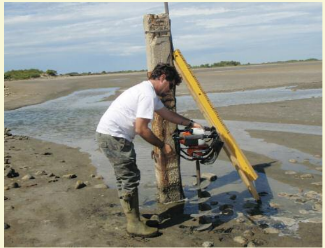
Installation d'échelles de niveaux.
