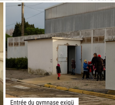
Entrée du gymnase exigüe
