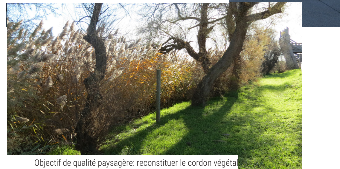
Vue site Décembre 2016: VUE APRES TRAVAUX.
