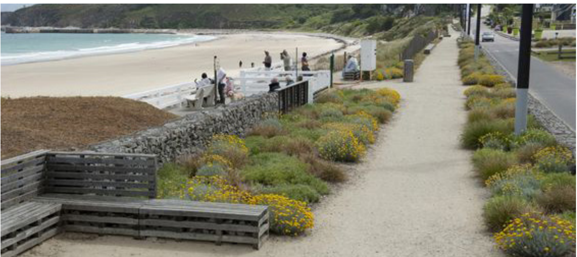
Sable d'Or Les Pins: aménagement d'une promenade le long de la RD 34 en front de mer
