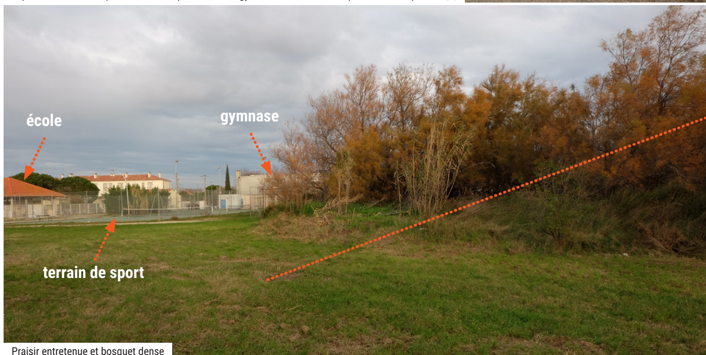
Espace dédié comme parvis de l'école primaire et du gymnase / réseau électrique aérien très présent [2]
