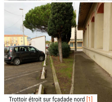
Trottoir étroit sur façade nord [1]
