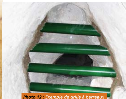
Photo 12 : Exemple de grille à barreaux condamnant l'accès à la cavité.
