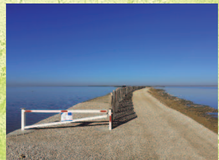
Travaux de réalisation de la plateforme DIGUE 2020 visant à tester la résistance d'une digue avec du matériau traité à la chaux © SYMADREM.
