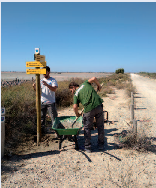
Installation de la signalétique.
