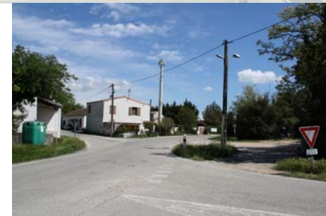
Carrefour RD 36b avec la « rue » du hameau particulièrement dégradé
