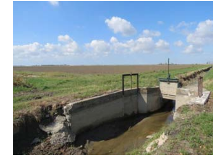
Entretien du réseau hydraulique
