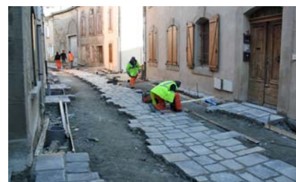
Chantier en cours en novembre 2013
