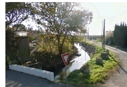
Gageron, un canal traverse le hameau
