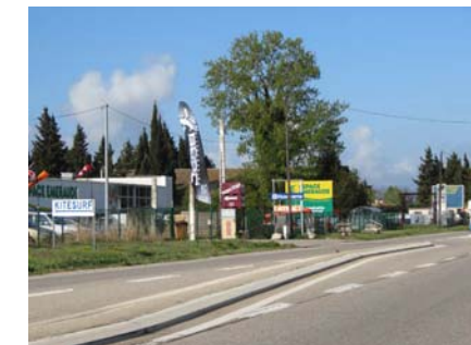
Abords banalisés de la RD 570
