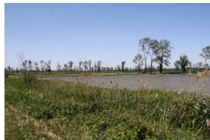
Cloisonnement lâche et en mauvais état d'un secteur de rizières
