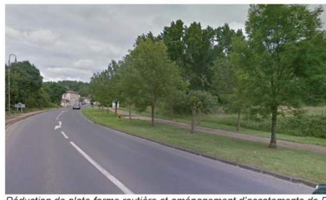
Réduction de plate-forme routière et aménagement d'accotements de RD Entrée d'agglomération (Coulon)
