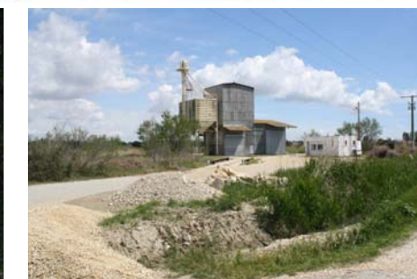
Silo dégradé en point d'appel
