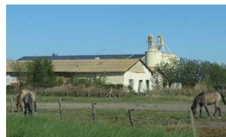
Hangars agricoles et silos situés à proximité
