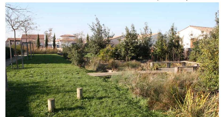
Platelage bois sur le bassin de rétention traité en mare
