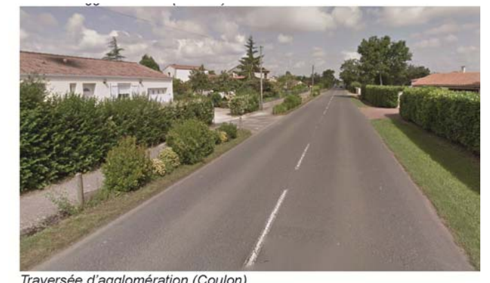
Traversée d'agglomération (Coulon)
