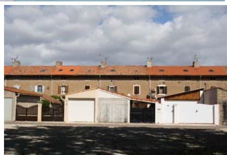
Transformations de la cité Solvay
