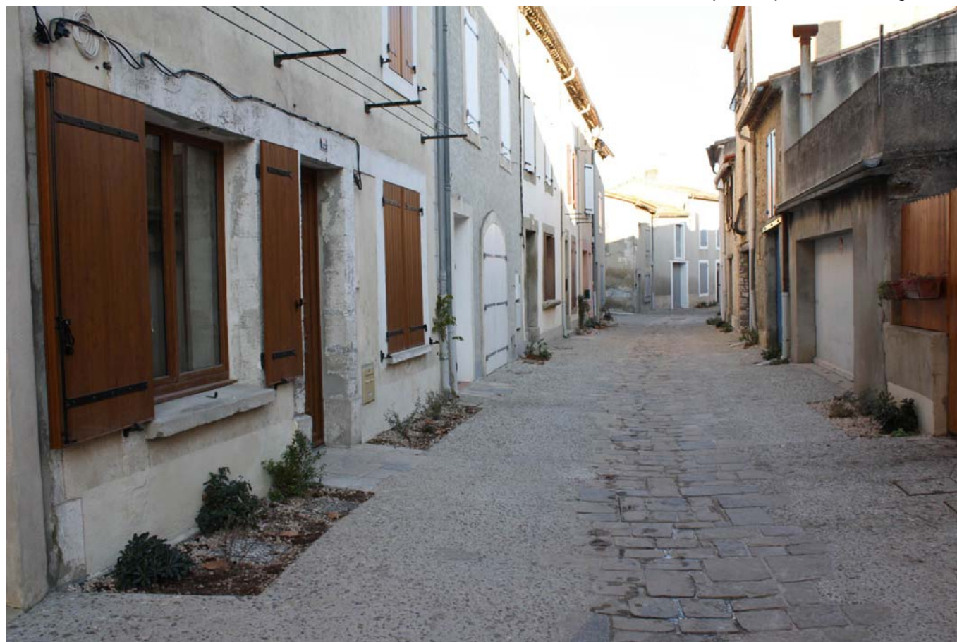
Rue réaménagée avec caniveau central et seuil d'habitation en pierre. Réservations pour planter en pied de façade et ponctuellement installer des treilles. Norme PMR.
