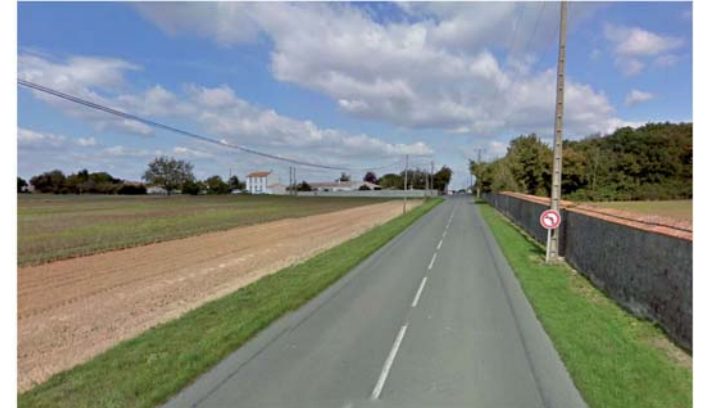
Plates-formes goudronnées réduites sur les routes secondaires pour réduire la vitesse automobile Village de Courson
