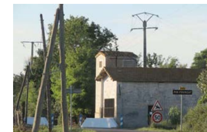
Station d'épuration à l'arrière du hameau
