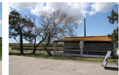
Corral en bord de RD 35 à revaloriser
