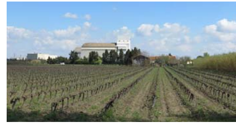
Silo à riz et vignoble
