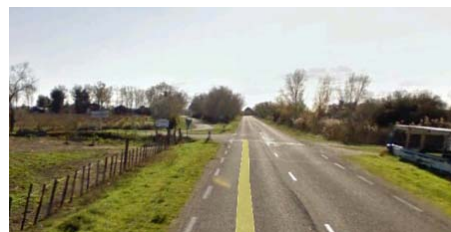
Cabanes de Cambon - carrefour non traité sur RD 38
