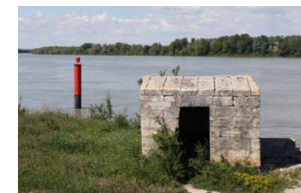
Prise d'eau ancienne
