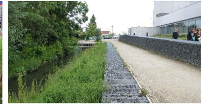
Nantes-Eco-quartier de Bottière-Chêneais : cheminement piéton vers la médiathèque en rive d'un ru re-anturé
