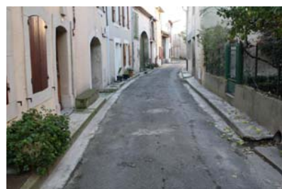
Rue avant travaux
