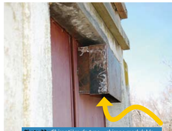
Photo 22 : Chiroptière de type « chicane modulable ».
