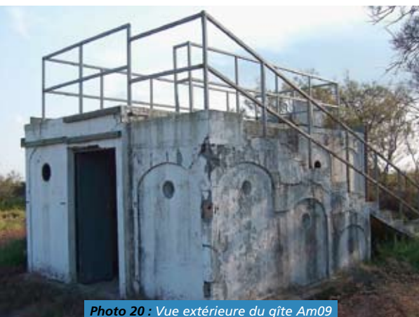
Photo 20 : Vue extérieure du gîte Am09 avant les aménagements.
