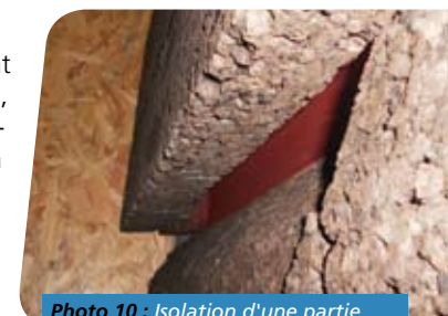
Photo 10 : Isolation d'une partie des murs avec du liège (gîte Am09).
