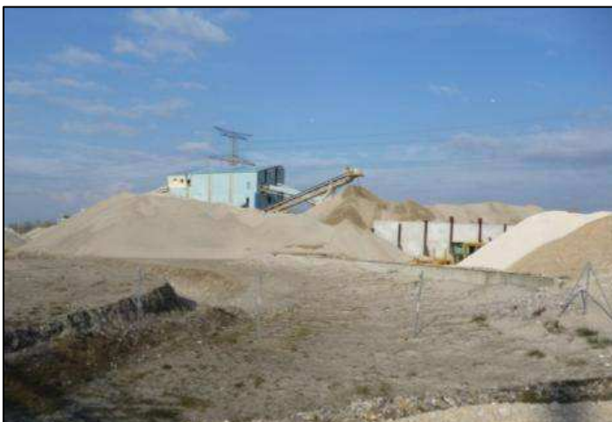
Figure 41 : Plateforme de traitement de la carrière LAFARGE
