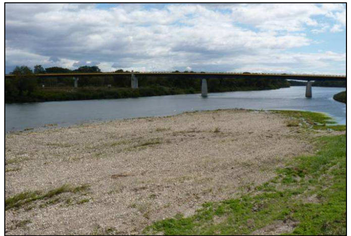
Figure 11 : Bancs de galets du Rhône, Pont Saint Esprit
