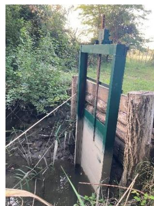
Figure 2 : Nouvelle martelière dans le cadre du CN au Mas de la Cure
