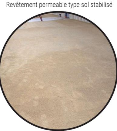
Revêtement perméable type sol stabilisé
