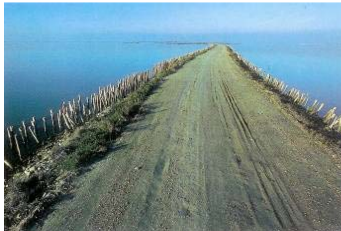
La digue à la mer (photo : A. Dervieux)
