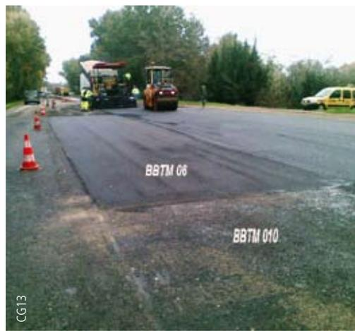
Sur la RD572, la pose des bandes de BBT-M06-CI2 n'a pas été faite pendant les travaux de réfection de chaussée. Ceci implique de faire revenir les engins sur le site pour enlever l'enrobé courant et le remplacer par le revêtement spécifique.
